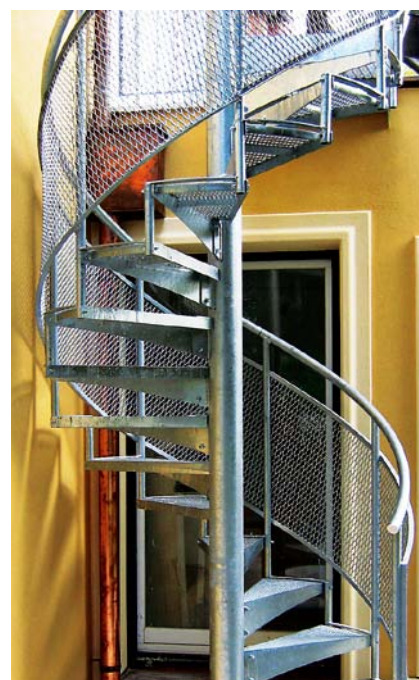
Spiraltreppen aus Streckmetall
