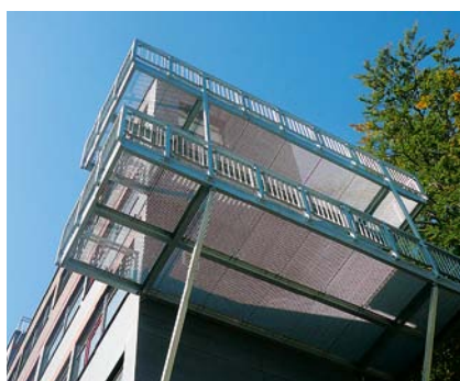
Begehbare Gitter der Stadiontribüne
